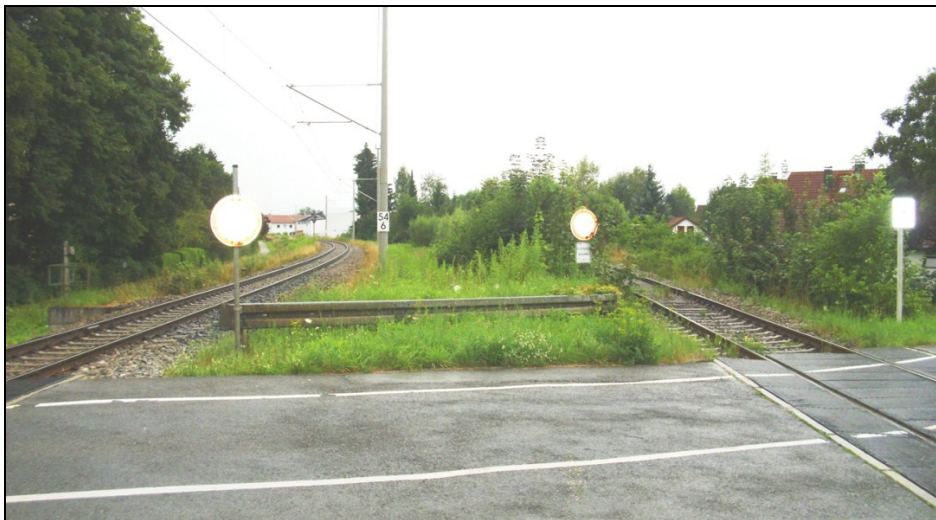
Foto vom Bahnübergang: „In der Au/Geistbühelstraße“ in Weilheim in Richtung Süden. Im Bild links: Hauptstrecke in Richtung Huglfing, im Bild rechts: Pfaffenwinkelbahn in Richtung Peißenberg.
